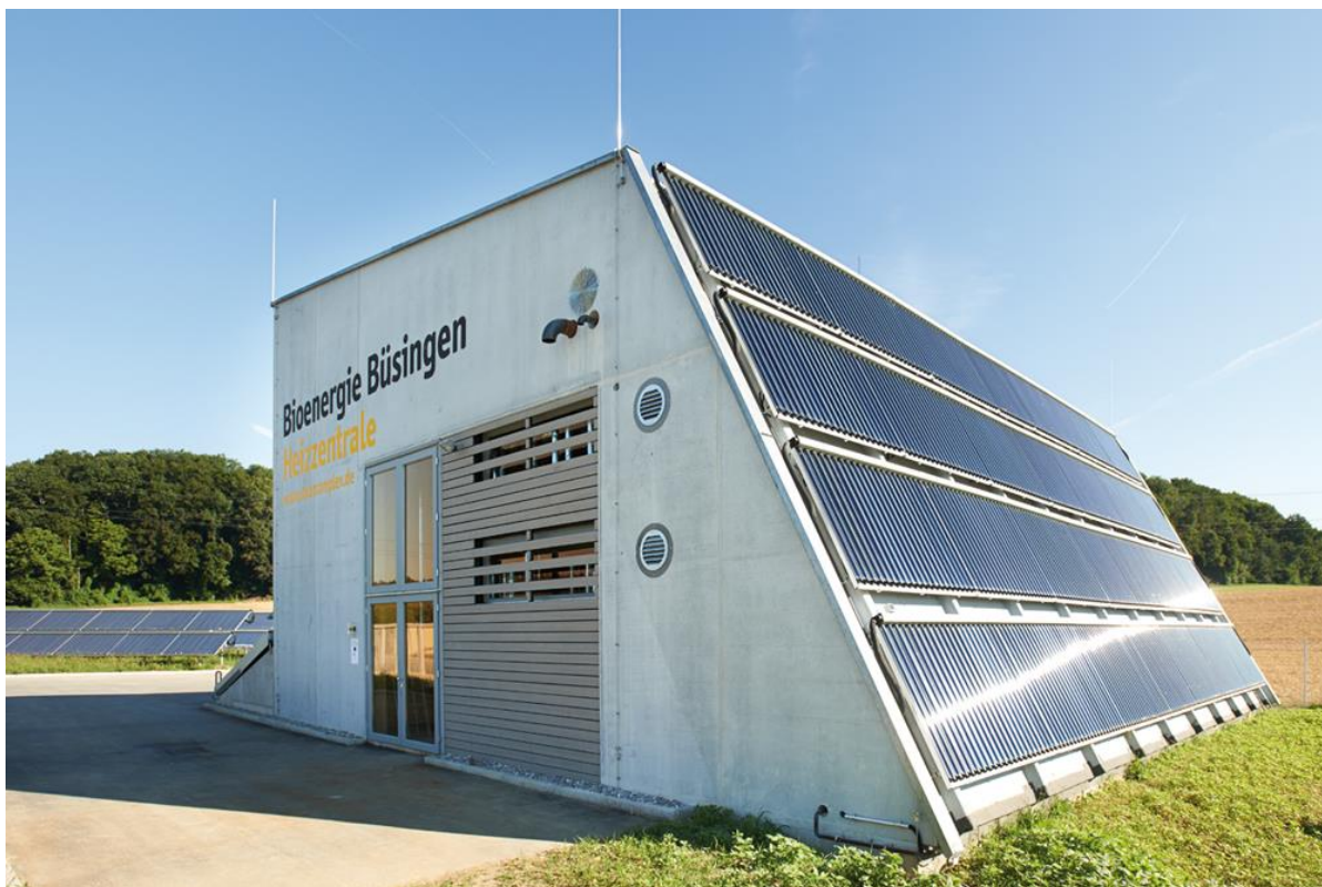
Slika 14: Toplinsko postrojenje u bioenergetskom naselju Büsingen. (Izvor: Solarcomplex)
