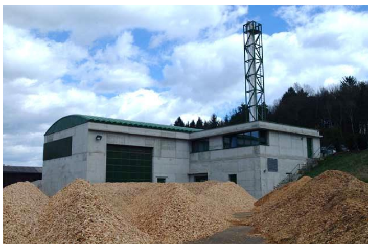
Slika 16. Toplana na biomasu snage sa kotlom na biomasu snage 1MW i vršnim kotlom na lož ulje snage 1.3 MW (Izvor: EEE GmbH); Koncept prikupljanja neiskorištenih resursa iz lokalnih šuma Gutenbaha sa privremenim skladištenjem
