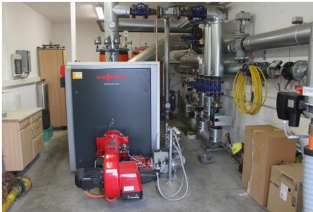
Vršni kotel na fosilna goriva v biomasnem DO v Nemčiji (vir: Rutz D.)
