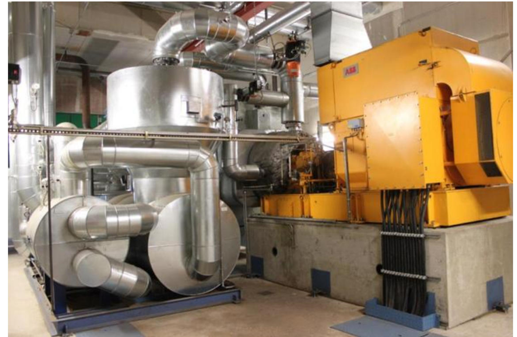
ORC sistem (1,520 kW e ) na Grünfüttertrocknungsgenossenschaft Kirchdorf v Nemčiji (Vir: Rutz D.)
