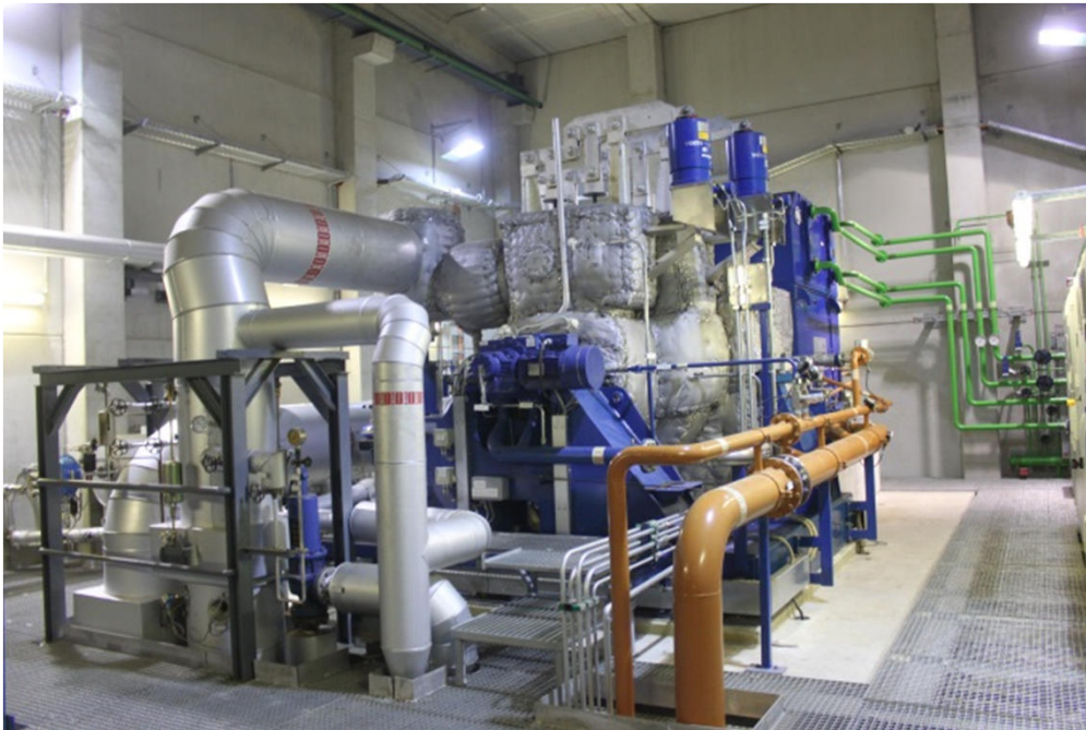
Parna turbina SPTTE na biomaso v Augsburg-u (kapaciteta: 80,000 t/a lesnih sekancev; 7.8 MW e ; 15 MW th ) (Vir: Rutz D.)
