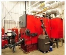
Toplovodni kotlovi ( $\leq 110$  °C)
