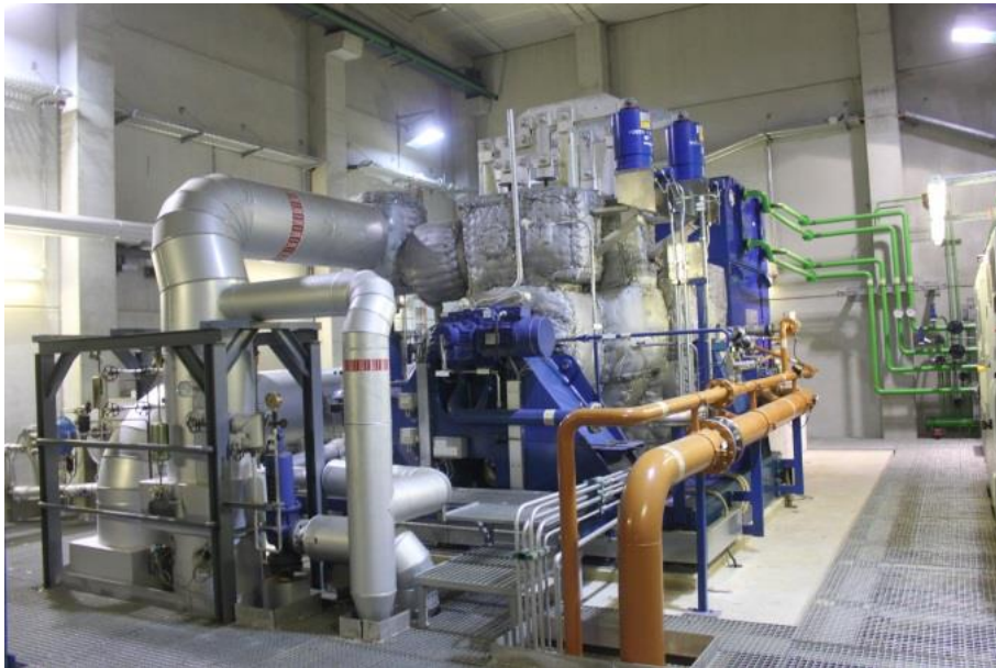
SPTE na lesne sekance in parna turbina v Augsburg (kapaciteta: 80,000 t/a sekancev; 7.8 MW el ; 15 MW th ) (Vir: Rutz D.)
