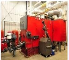
Котли за топла вода ( $\leq 110^{\circ}\text{C}$ )
