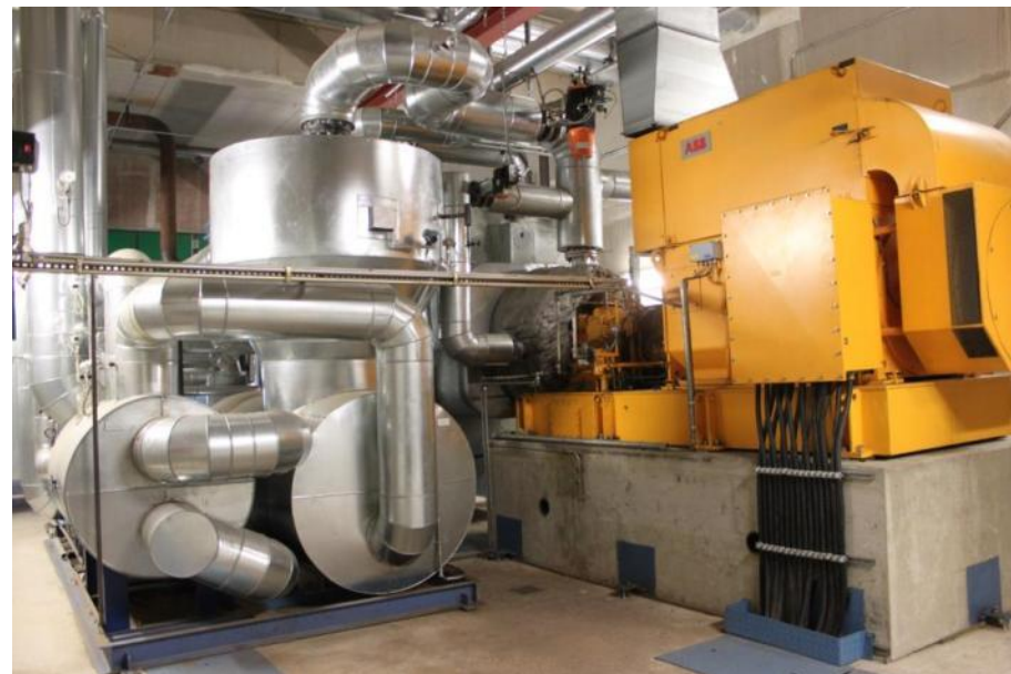
ORC систем (1,520 kW el ) во Grünfütterrocknungsgenossenschaft Kirchdorf Германија, (Извор: Rutz D.)
