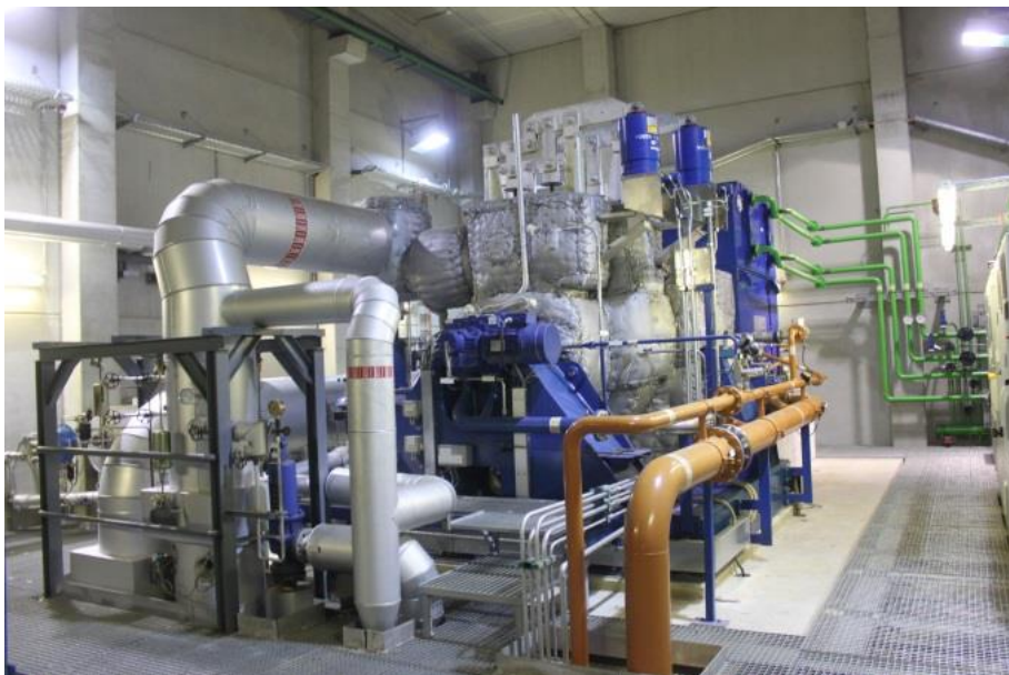
CHP на дрвен чипс и неговата парта турбина во Аугзбург (капацитет: 80000 t дрвен чипс/год, 7,8 MWe el , 17 MW th ) (Извор: Rutz D.)
