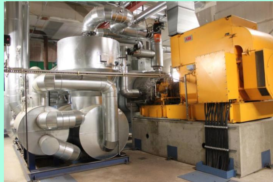
ORC sistem (1 520 kWel) u Grünfuttertrocknungsgenossenschaft Kirchdorf a.H. eG u Njemačkoj
