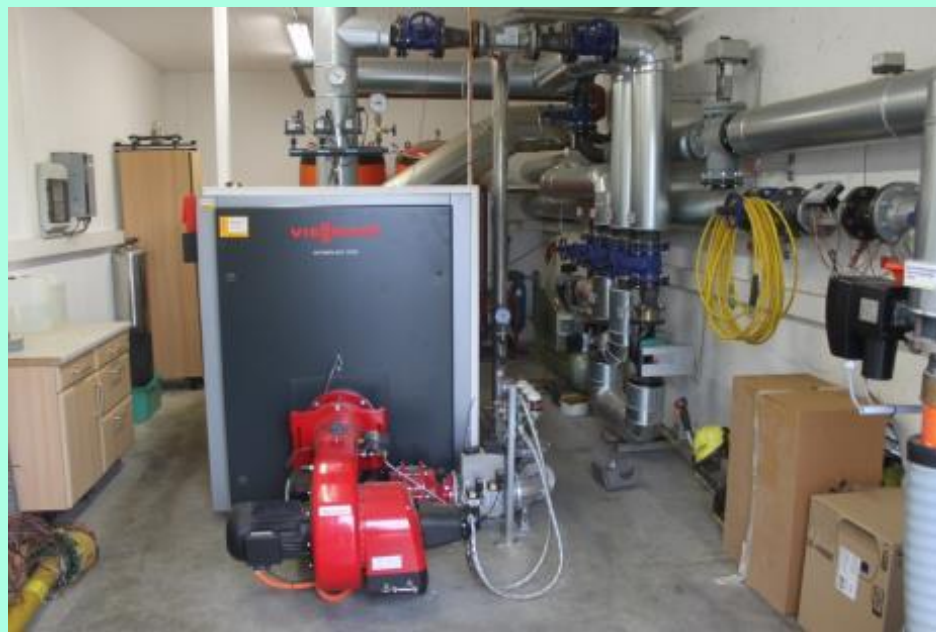
Vršni kotao na lož ulje u sklopu bioplinskog postrojenja u Njemačkoj u sklopu postrojenja na biomasu u Češkoj (Izvor: Rutz D.)
