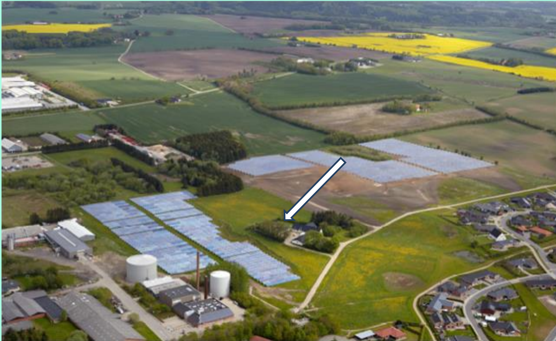
Toplinski spremnik u obliku bušotine u sklopu solarnog CTS-a u Brædstrupu, Danska
