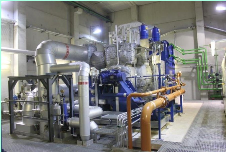
Kogeneracijsko postrojenja na drvenu sječku u Augsburgu, Njemačka (kapacitet 80 000 t/god drvene sječke; 7,8 MWel; 15 MWth)
