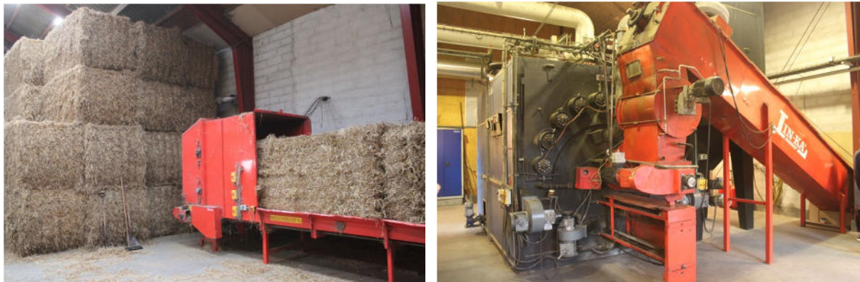
Slika 17: Transportni sistem bal slame (levo) in 1.6 MW kotel na slamo v Ballen-Brundby, Danska (Vir: Rutz D.)
