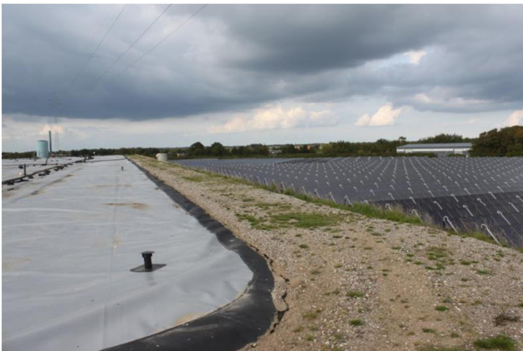
Slika 45: Rob izolirane jame solarnega DH sistema Gram, Danska (Vir: Rutz D.)
