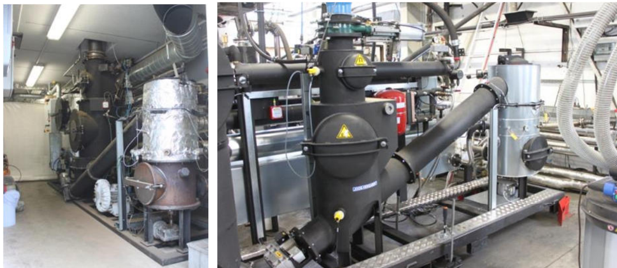
Slika 21: Sistem uplinjevalnja majhnega obsega v kontejnerju (levo) in tokom proizvodnje tehnologije (desno) proizvajalca „SpannerRE 2 “ (Vir: Rutz D.)
