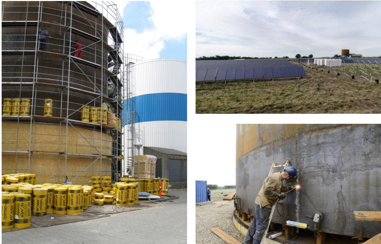
Slika 43: Postavitev jeklenih rezervoarjev Hjallerup District Heating. (Vir: www.hjallerupfjernvarme.dk )
