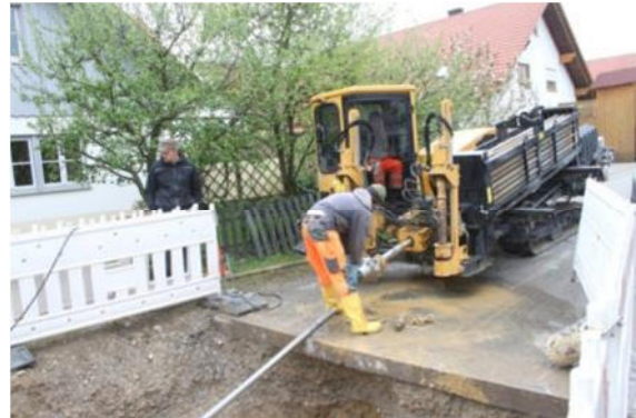
Slika 53: Vrtalni stroj (Vir: Rutz)
