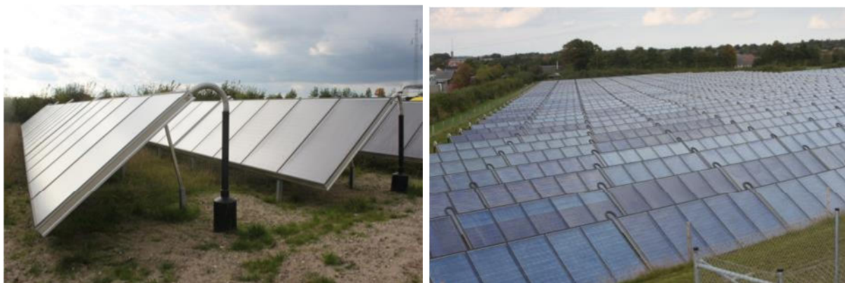
Slika 8: Ploščati kolektorji nameščeni na tla solarnega sistema daljinskega ogrevanja v mestu Gram, Danska (Vir: Rutz D.)
