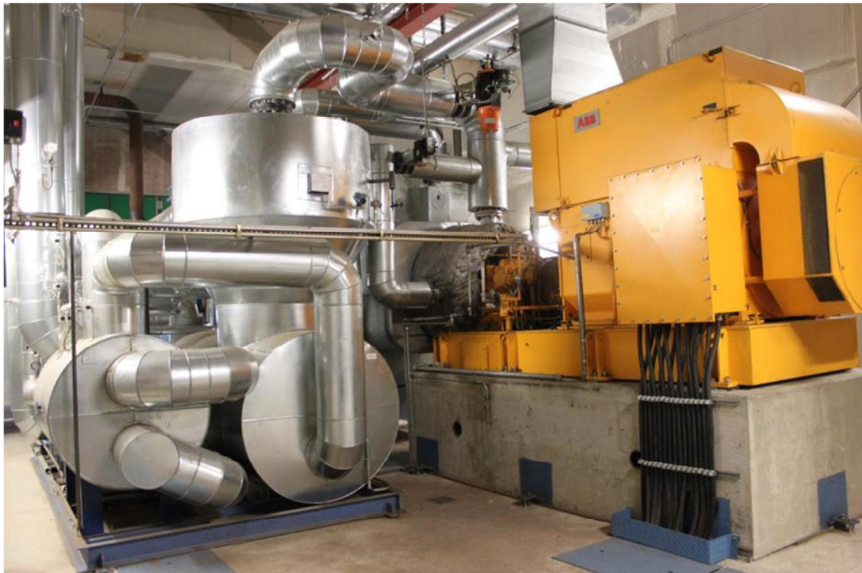
Slika 20: ORC sistem (1,520 kW el ) institucije Grünfüttertrocknungsgenossenschaft v naselju Kirchdorf a.H. eG v Nemčiji (Vir: Rutz D.)
