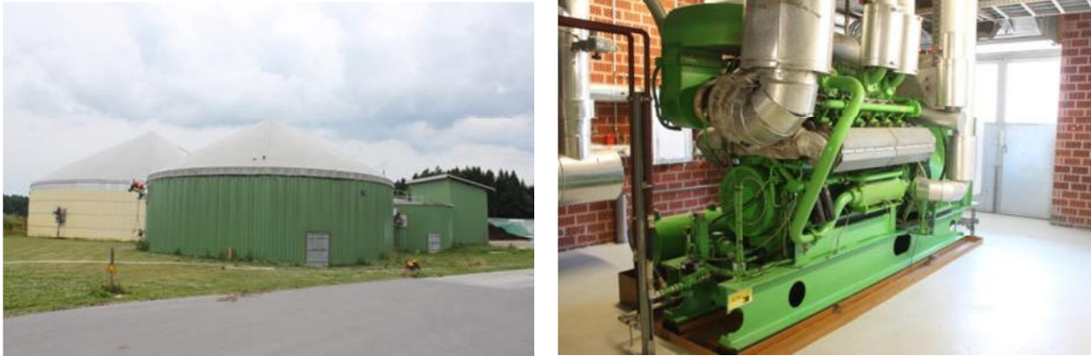
Slika 23: Reaktor bioplinarne (levo) in SPTE enota (desno) (Vir: Rutz D.)
