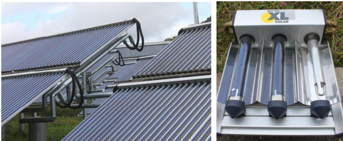
Slika 7: Vakuumski cevni kolektorji nameščeni na tla (levo) solarnega daljinskega sistema ogrevanja v mestu Büsingen, Nemčija in primer uporabljenih kolektorjev (desno), ki prikazuje cev medija U oblike ter tehnologijo paraboličnega koncentradorja (Compound Parabolic Concentrator - CPC) (Vir: Rutz D.)
