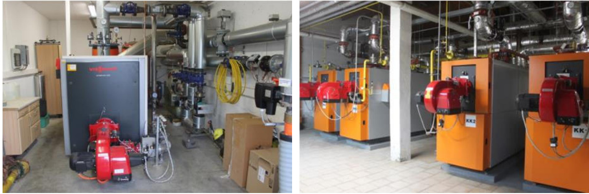
Slika 40: Vršni kotli za na ELKO v bioplinarni v Nemčiji (levo) in kotli na plin (desno) (Vir: Rutz D.)
