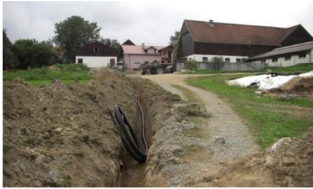
Slika 52: Namestitev cevovoda do objektov (Vir: ThermoFlex Isolierprodukte GmbH)
