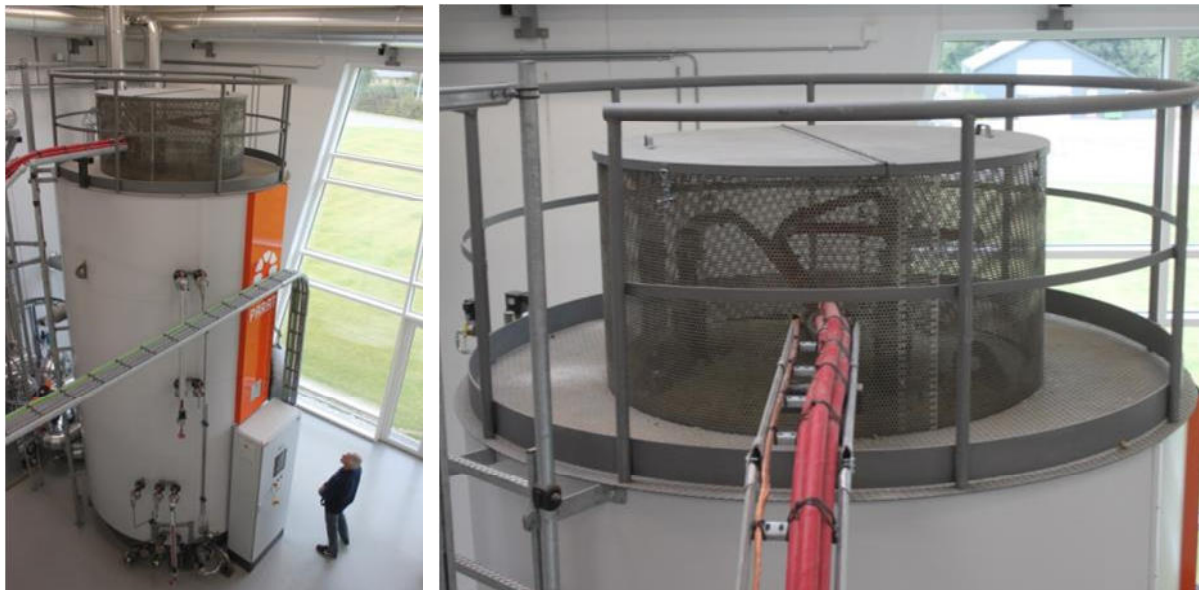
Slika 33: Električni kotel 10 MW in 14.4 m 3 kapacitete sončnega daljinskega ogrevanja v Gram, Danska (Vir: Rutz D.)
