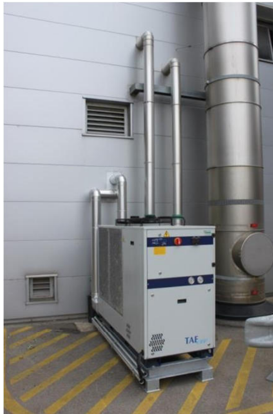
Slika 68: Zračno hlajeni hladilnik, ki uporablja toploto iz obrata za sežiganje smeti v Avstriji (Vir: Rutz D.)
