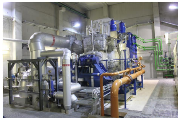
Slika 19: SPTE obrat na lesne sekance in pri tem uporabljena parna turbina, Stadtwerke Augsburg Energie GmbH v Nemčiji (kapaciteta: 80,000 t/a lesnih sekancev; 7.8 \text{ MW}_{\text{el}} ; 15 \text{ MW}_{\text{th}} ) (Vir: Rutz D.)
