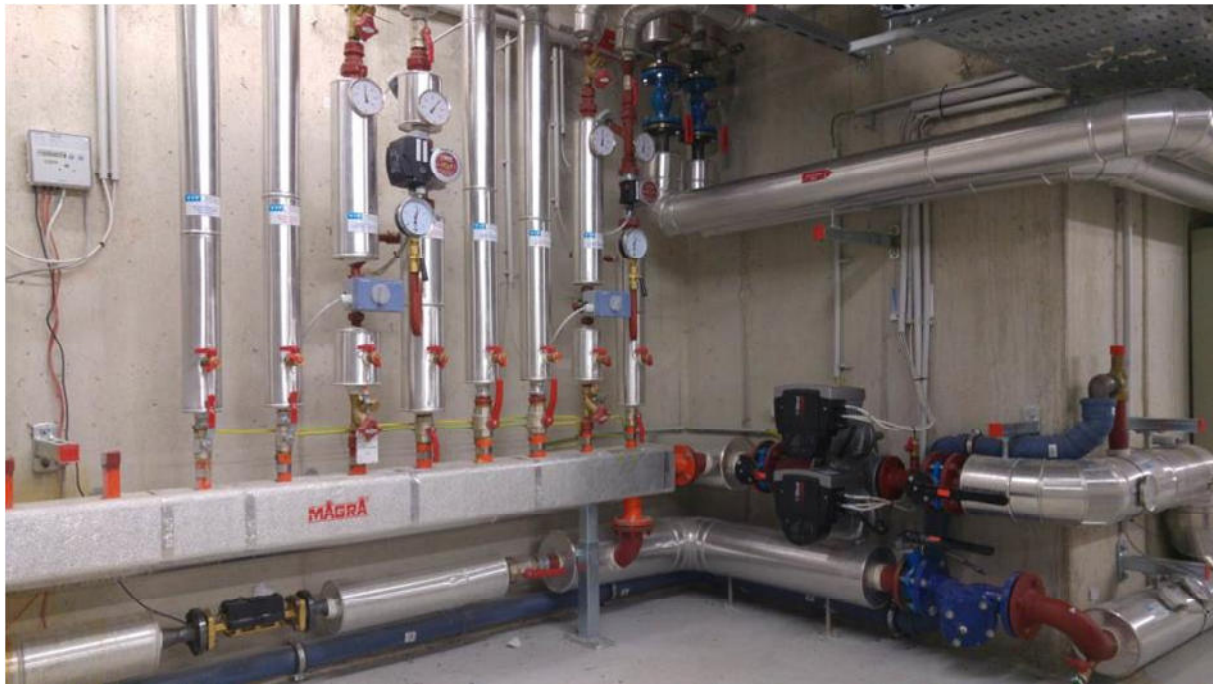
Slika 58: Distribucija toplote v obratu, ki ga oskrbuje DH sistem (Vir: Güssing Energy Technologies)
