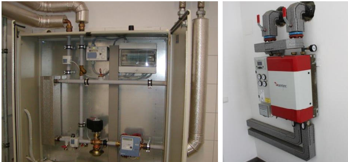
Slika 55: Toplotne podpostaje z toplotnim izmenjevalcem, kontrolno enoto, ventili in toplotnim števcem (levo) (Vir: Güssing Energy Technologies) in toplotna podpostaja (vključuje toplotni izmenjevalec) v Achental, Germany (Vir: Rutz)
