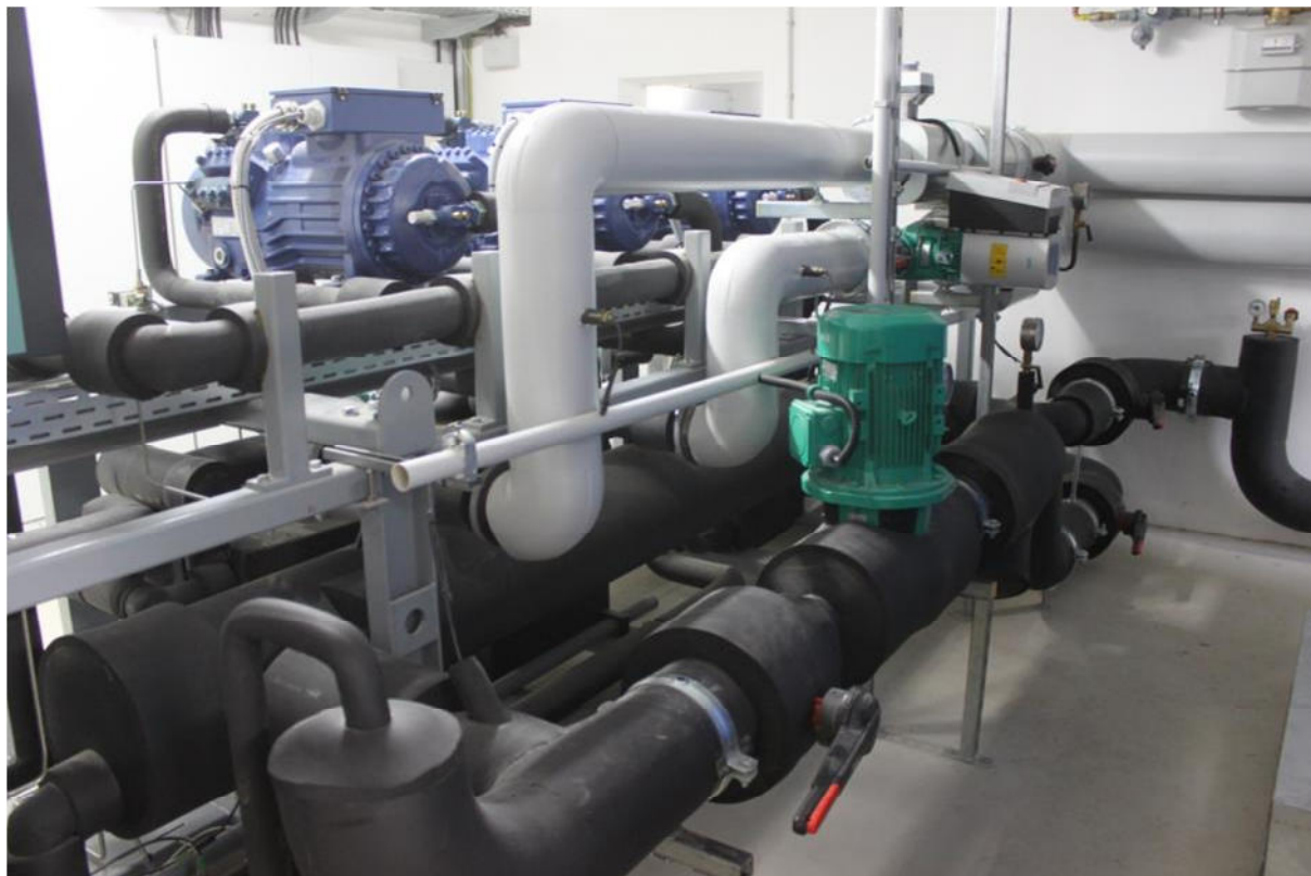
Slika 34: 440 kW toplotna črpalka v majhnem solarnem omrežju daljinskega ogrevanja v Dollnstein, Nemčija (Vir: Rutz D.)
