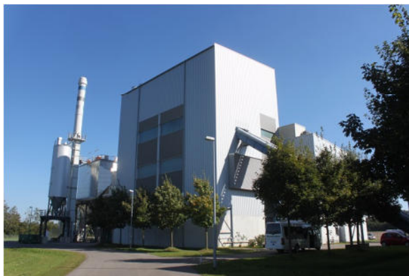
Slika 19: SPTE obrat na lesne sekance in pri tem uporabljena parna turbina, Stadtwerke Augsburg Energie GmbH v Nemčiji (kapaciteta: 80,000 t/a lesnih sekancev; 7.8 \text{ MW}_{\text{el}} ; 15 \text{ MW}_{\text{th}} ) (Vir: Rutz D.)
