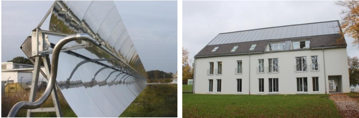
Slika 9: Parabolični kolektorji eksperimentalnega postrojenja (levo) in v streho objekta nameščeni solarni kolektorji manjšega sistema daljinskega ogrevanja v mestu Bad Aibling, Nemčija (Vir: Rutz D.)
