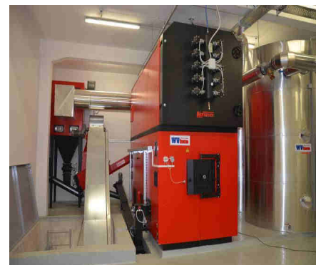
Boilerrom Novo Mesto
