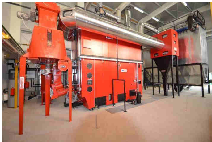
Boiler 1,5 MW Kozje
