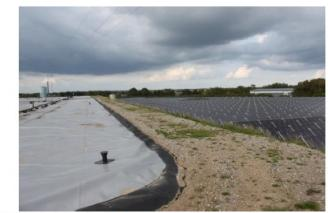
Slika 33. Uvećani prikaz ivičnog dela skladišta toplice u obliku izolovane jame u sklopu solarnog SGD u Gramu, Danska (Izvor: Rutz D.)
