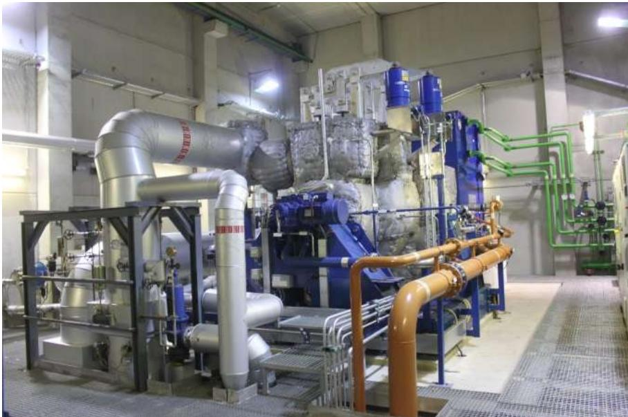
Kogeneraciono postrojenje na drvnu sečku i parna turbina postrojenja Stadtwerke Augsburg Energie GmbH u Nemačkoj (kapacitet 80 000 t/god drvne sečke; 7,8 MWel; 15 MWth) (Izvor: RutzD.)
