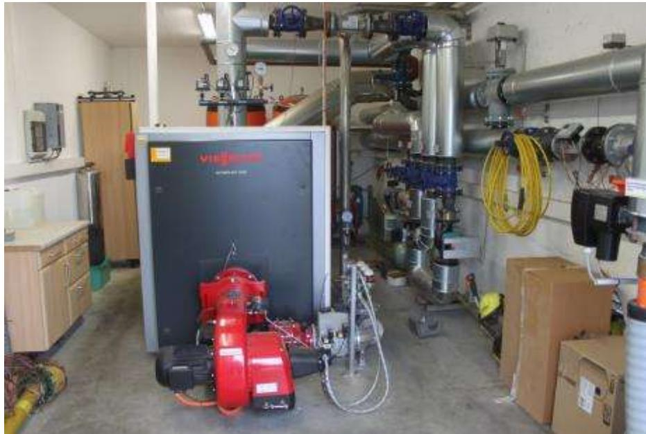
Vršni kotao na lož ulje u sklopu biogasnog postrojenja u Nemačkoj (levo) i gasni kotlovi (desno) u sklopu postrojenja na biomasu u Češkoj (Izvor: RutzD.)
