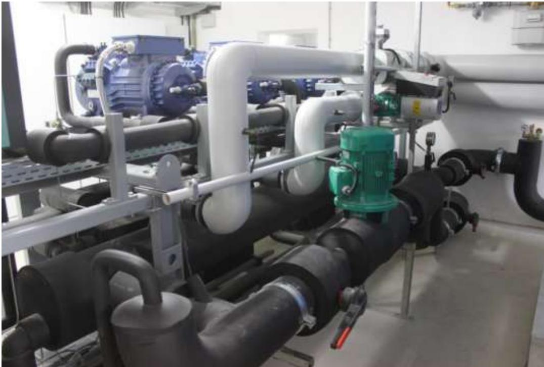
Toplotna pumpa koja koristi podzemne vode kao izvor toplote (instalisana snaga 440 kW) u malom SDG sa solarnim kolektorima u Dollnsteinu, Nemačka (Izvor: Rutz D.)
