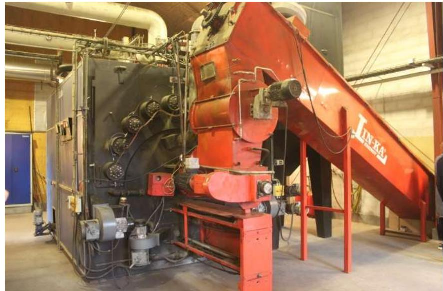
Sistem za neprekidno snabevanje balama slame (levo) i kotao na slamu snage 1,6 MW u Ballen-Brundby u, Danska (Izvor: RutzD.)
