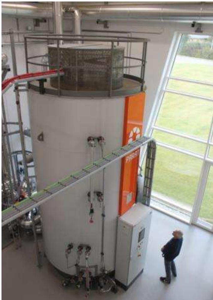
Električni grejač tople vode instalisane snage 10 MW, kapaciteta 14,4m<sup>3</sup> koji se nalazi u gradu Gram (Danska) koji je priključen na SDG (Izvor: Rutz D.)
