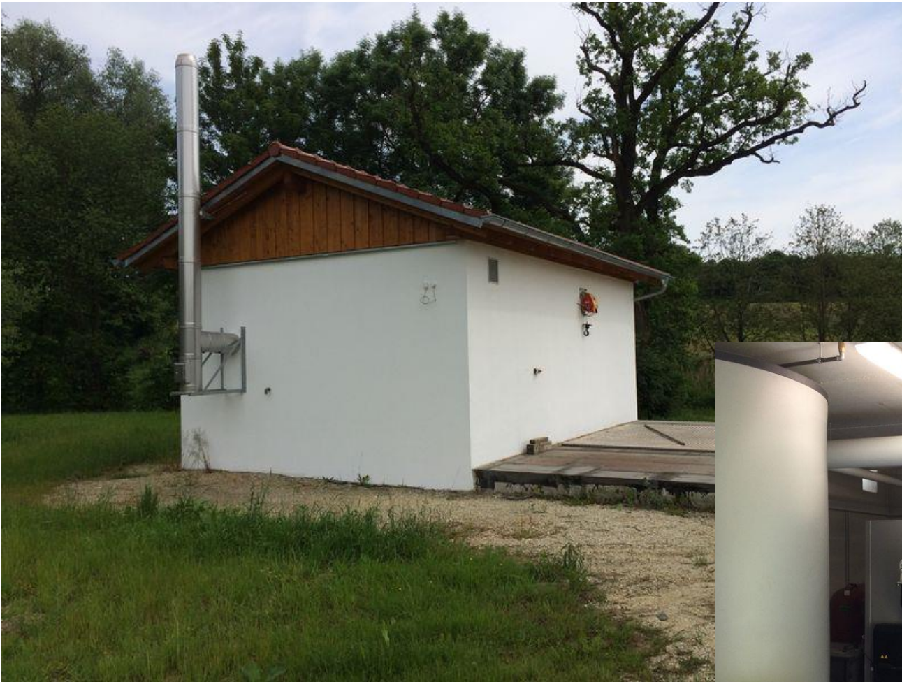
Toplinsko postrojenje Thann, Snaga: 220 kW
