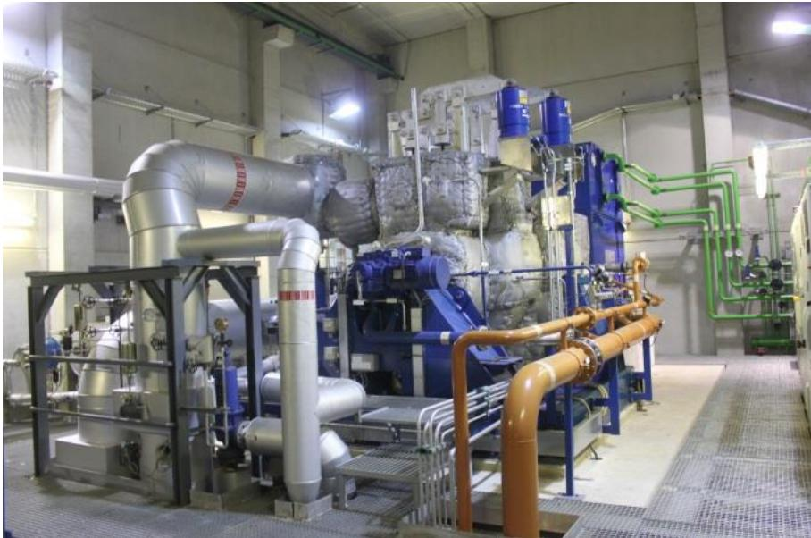
Kogeneracijsko postrojenje na drvnu sječku te njegova **parna turbina** u Augsburgu (kapacitet: 80,000 t/god drvne sječke; 7.8 MWel; 15 MWth) (Izvor: Rutz D.)
