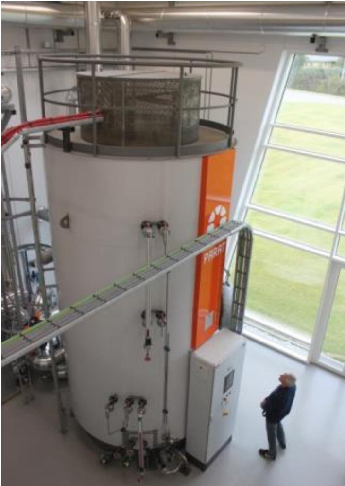
Električni bojler snage 10 MW te kapaciteta  $14.4 \text{ m}^3$  u CTS-u u Gramu, Danska (Izvor: Rutz D.)
