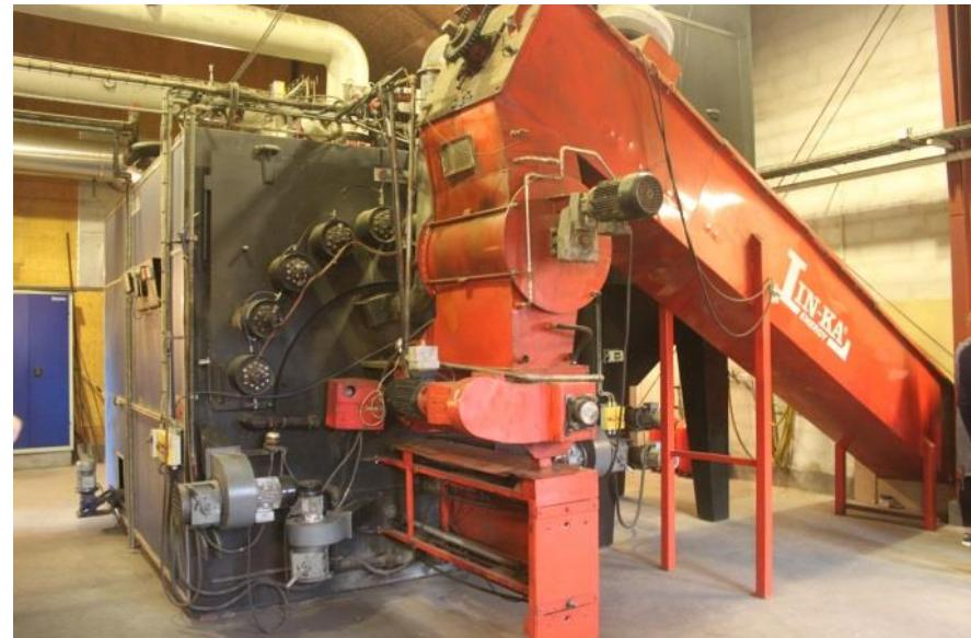
Uređaj za dobavu biomase do kotla (lijevo) te kotao snage 1,6 MW koji koristi bale slame u Ballen-Brundby, Danska (Izvor: Rutz D.)
