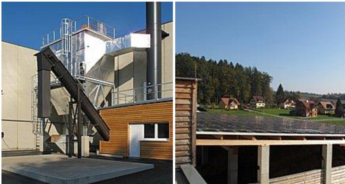
**Slika 26.** Pročišćavanje dimnih plinova u kotlovnici na biomasu u Stainzu, koja koristi elektrostatički filter (lijevo); Fotonaponski paneli instalirani snage  $257 \text{ kW}_P$  na krovu skladišta za šumsku biomasu (Izvor: nahwaerme.at)
