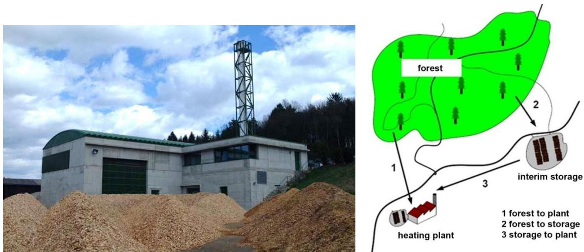
Slika 23. Kotlovnica na biomasu sa kotlom snage 1 MW te vršnim kotlom snage 1,3 MW (Izvor: EEE GmbH); Koncept iskorištavanja neiskorištenih resursa iz lokalnih šuma u Güttenbachu sa skladištem drvne biomase
