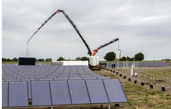
Slika 8. Postrojenje u izgradnji: sunčevi kolektori i novi spremnik topline, izvor: CTS u Hjallerupu
