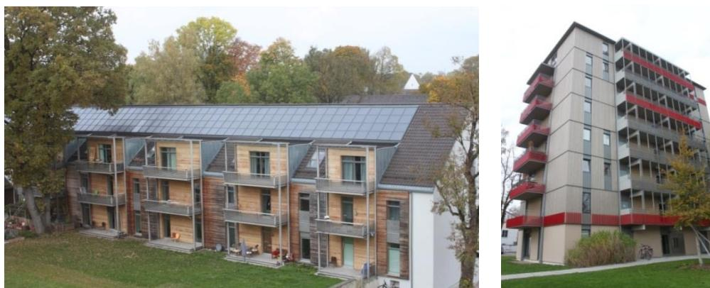
Slika 18. Sunčevi kolektori (lijevo) te drvena zgrada sa osam katova u Bad Aiblingu (Izvor: D. Rutz, WIP)
