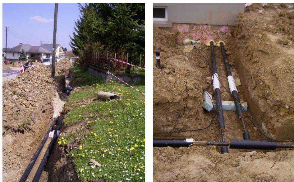
Slika 22. Postavljanje distribucijskih cijevi u Güssingu (lijevo) te priključak za kućanstva (desno) (Izvor: Güssinger Fernwärme GmbH)
