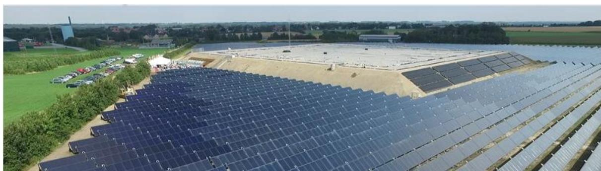
**Slika 5. Novo proizvodno postrojenje izgrađeno 2015., koje uključuje fotonaponske panele na južnoj strani sezonskog spremnika topline**
