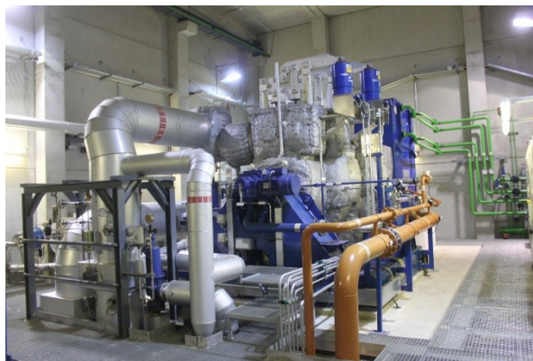
Slika19. Kogeneraciono postrojenje na drvnu sečku i parna turbina postrojenja Stadtwerke Augsburg Energie GmbH u Nemačkoj (kapacitet 80 000 t/god drvne sečke; 7,8 MW el ; 15 MW th ) (Izvor: RutzD.)
