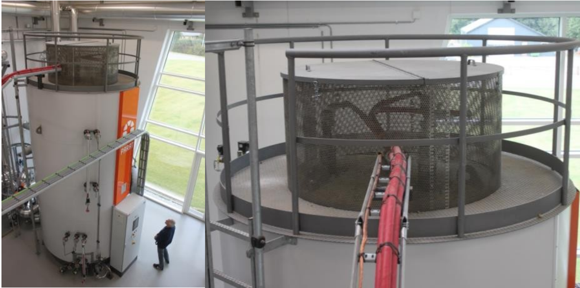
Slika33. Električni grejač tople vode instalisane snage 10 MW, kapaciteta 14,4m 3 koji se nalazi u gradu Gram (Danska) koji je priključen na SDG (Izvor: Rutz D.)
