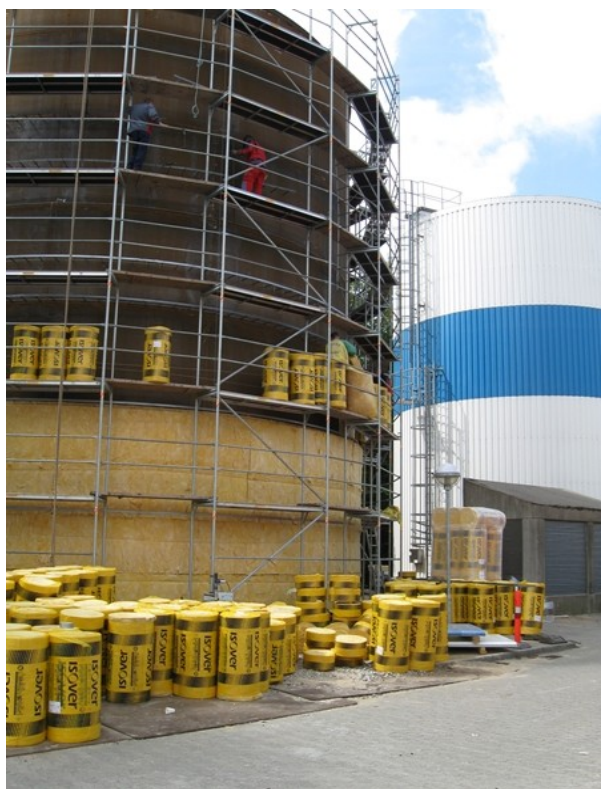
Slika 31. Izgradnja dva nova skladišta toplote u obliku čeličnog rezervoara u SDG Hjallerup (levo) i izgradnja iste vrste skladišta toplot povezanog sa solarnim kolektorima i kotlom na slamu. Više o SDG u Hjallerupu može se saznati u izveštaju o primerima najbolje prakse Laurberg Jensen et al.(2016) (Izvor: http://www.hjallerupfjernvarme.dk )
