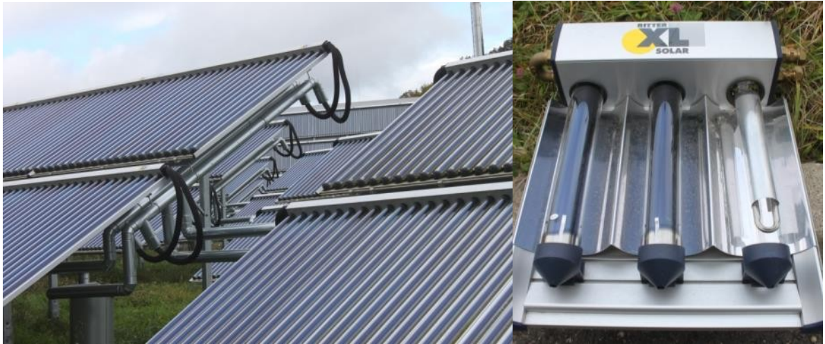
Slika7. Vakuumski kolektori postavljeni na zemlju (levo) koji su deo SDG u Büsingenu u Nemačkoj i uzorak ove vrste kolektora (desno) koji prikazuje U cev u desnoj cevi, kao i složeni parabolični koncentrisani kolektor (eng. Compound Parabolic Concentrator - CPC) (Izvor: Rutz D.)
