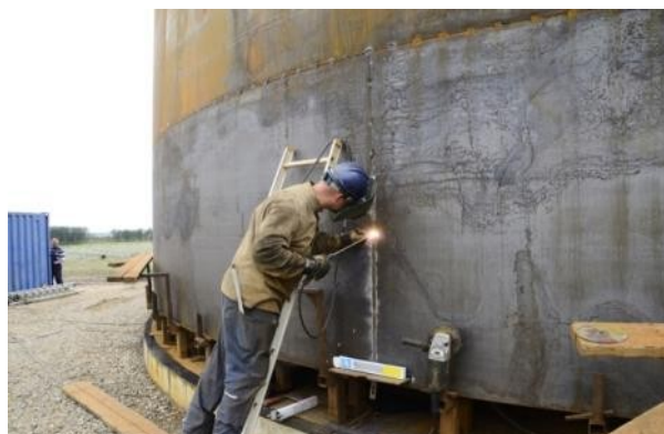
Slika 31. Izgradnja dva nova skladišta toplote u obliku čeličnog rezervoara u SDG Hjallerup (levo) i izgradnja iste vrste skladišta toplot povezanog sa solarnim kolektorima i kotlom na slamu. Više o SDG u Hjallerupu može se saznati u izveštaju o primerima najbolje prakse Laurberg Jensen et al.(2016) (Izvor: http://www.hjallerupfjernvarme.dk )
