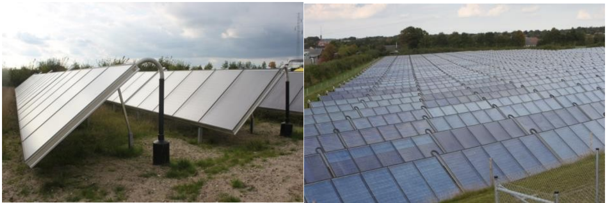
Slika8. Pločasti kolektori postavljeni na zemlju koji su deo SDG u Gramu u Danskoj (Izvor: RutzD.)
