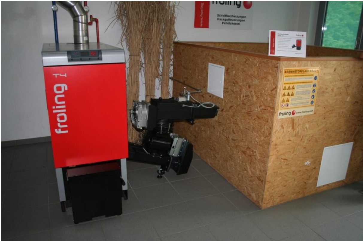
Slika 10. Mali sistem grejanja koji koristi drvnu sečku (instalirana snaga 24-50 kW) sa kotlom (levo), sistemom za neprekidno snabdevanje biomasaom (sredina) i skladište drvne sečke (desno) u Frölingu (Izvor: Rutz D.)
