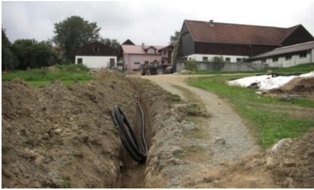
Slika 39 Polaganje cevi za SDG na selu (Izvor: Thermaflex Isolierprodukte GmbH)
