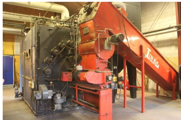
Slika 17. Sistem za neprekidno snabevanje balama slame (levo) i kotao na slamu snage 1,6 MW u Ballen-Brundby u, Danska (Izvor: RutzD.)
