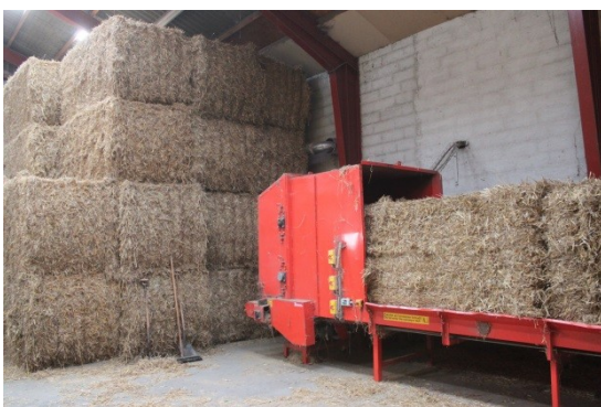
Slika 17. Sistem za neprekidno snabevanje balama slame (levo) i kotao na slamu snage 1,6 MW u Ballen-Brundby u, Danska (Izvor: RutzD.)
