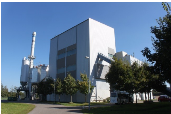
Slika19. Kogeneraciono postrojenje na drvnu sečku i parna turbina postrojenja Stadtwerke Augsburg Energie GmbH u Nemačkoj (kapacitet 80 000 t/god drvne sečke; 7,8 MW el ; 15 MW th ) (Izvor: RutzD.)
