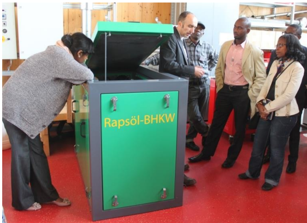
Slika 19. CHP postrojenje koje koristi ulje od uljane repice (Izvor: Rutz D.)
