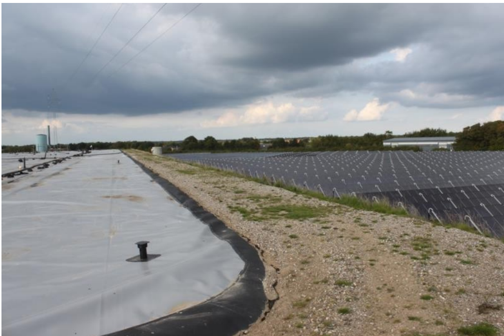
Slika 33. Uvećani prikaz ivičnog dela skladišta toplote u obliku izolovane jame u sklopu solarnog SDG u Gramu, Danska (Izvor: Rutz D.)
