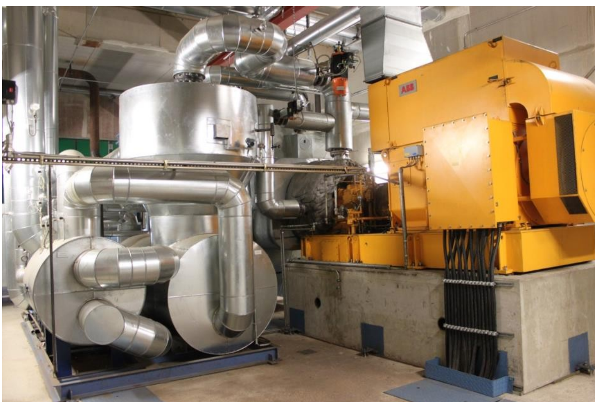
Slika 13. ORC sistem (1 520 kW el ) u Grünfuttertrocknungsgenossenschaft Kirchdorf a.H. eG u Nemačkoj (Izvor: Rutz D.)
