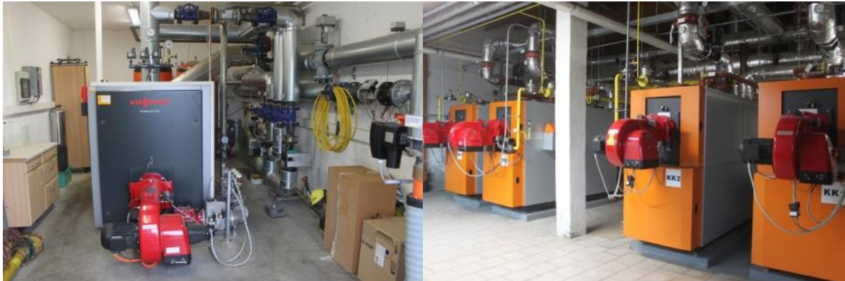
Slika40. Vršni kotao na lož ulje u sklopu biogasnog postrojenja u Nemačkoj (levo) i gasni kotlovi (desno) u sklopu postrojenja na biomasu u Češkoj (Izvor: RutzD.)
