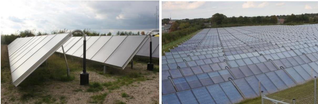
**Abbildung 8:** Flachkollektoren der Freiflächenanlage des solaren Nahwärmenetzes in Gram, Dänemark (Quelle: Rutz D.)
