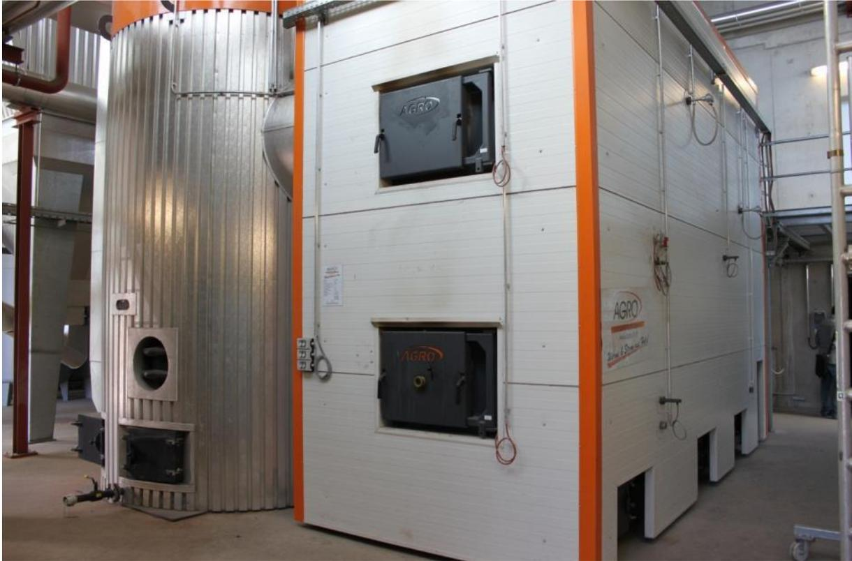
**Abbildung 16:** Mittelgroßes Hackschnitzelheizsystem (3,000 kW Kapazität) des Biomassehofes Achental in Deutschland mit dem Kessel (rechts) und dem Puffertank (links) (Quelle: Rutz D.)
