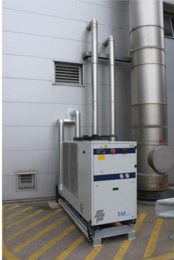
Abbildung 68: Luftgekühlte Kältemaschine die mit der Abwärme einer Müllverbrennungsanlage in Österreich betrieben wird (Quelle: Rutz D.)
