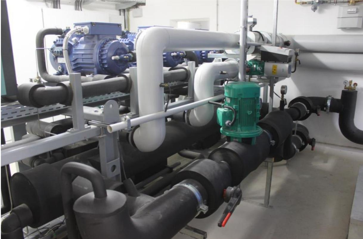
Abbildung 34: 440 kW Grundwasser-Wärmepumpe im solaren Nahwärmenetz von Dollnstein, Deutschland (Quelle: Rutz D.)
