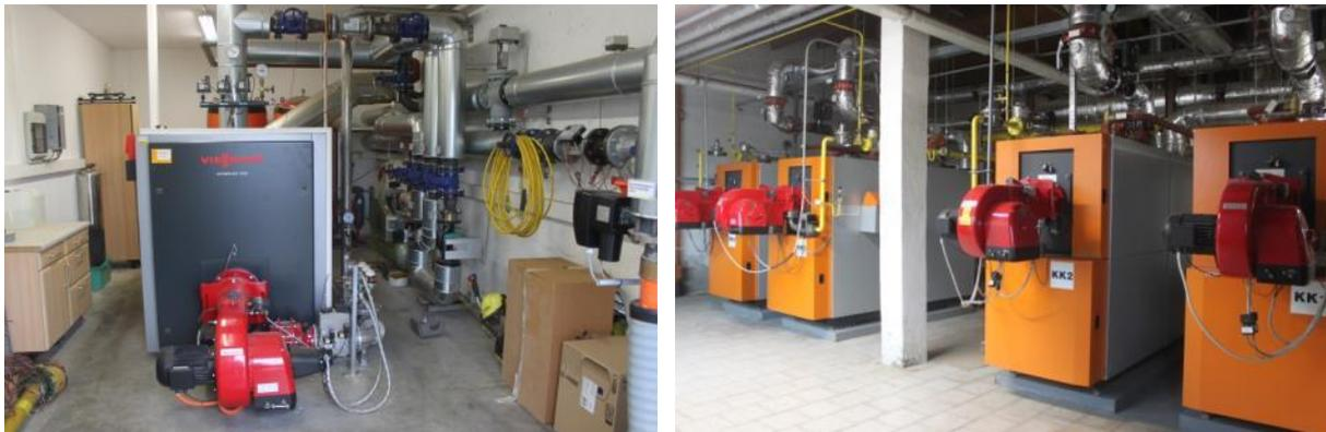
Abbildung 40: Spitzenlastkessel für Heizöl an einer Biogasanlage in Deutschland (links) und für Erdgas an einer Biomasseanlage in Tschechien (rechts) (Quelle: Rutz D.)
