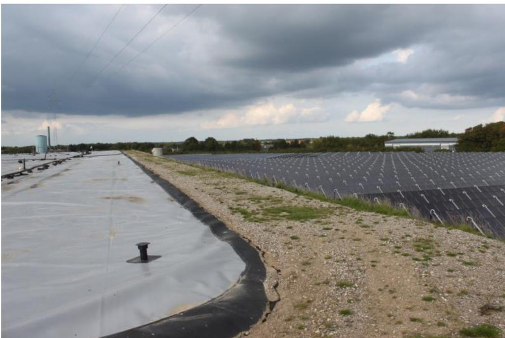
Abbildung 45: Rand eines Speicherbeckens einer Solarthermie-Fernwärmanlage in Gram, Dänemark (Quelle: Rutz D.)
