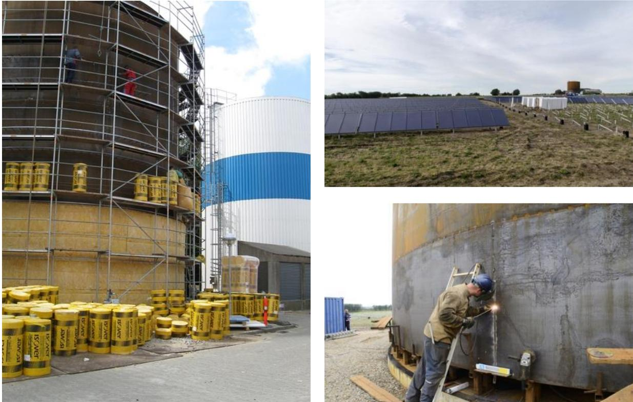
**Abbildung 43:** Bau von Stahlspeichern der Hjallerup Fernwärme. Links: Bau zweier neuer Stahlspeicher für die KWK in Hjallerup. Rechts: Bau eines neuen Stahlspeichers für ein Solarkollektorfeld und einen strohbefeuerten Kessel. Mehr über die Hjallerup Fernwärme ist im Best Practice Bericht von Laurberg Jensen et al. (2016) zu finden (Quelle: [www.hjallerupfjernvarme.dk](http://www.hjallerupfjernvarme.dk))
