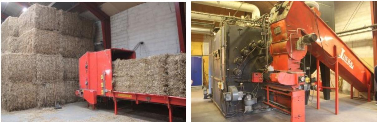
**Abbildung 17:** Brennstoffzuführung für Strohballen (links) und 1,6 MW Strohballenfeuerungsanlage in Ballen-Brundby, Dänemark (Quelle: Rutz D.)
