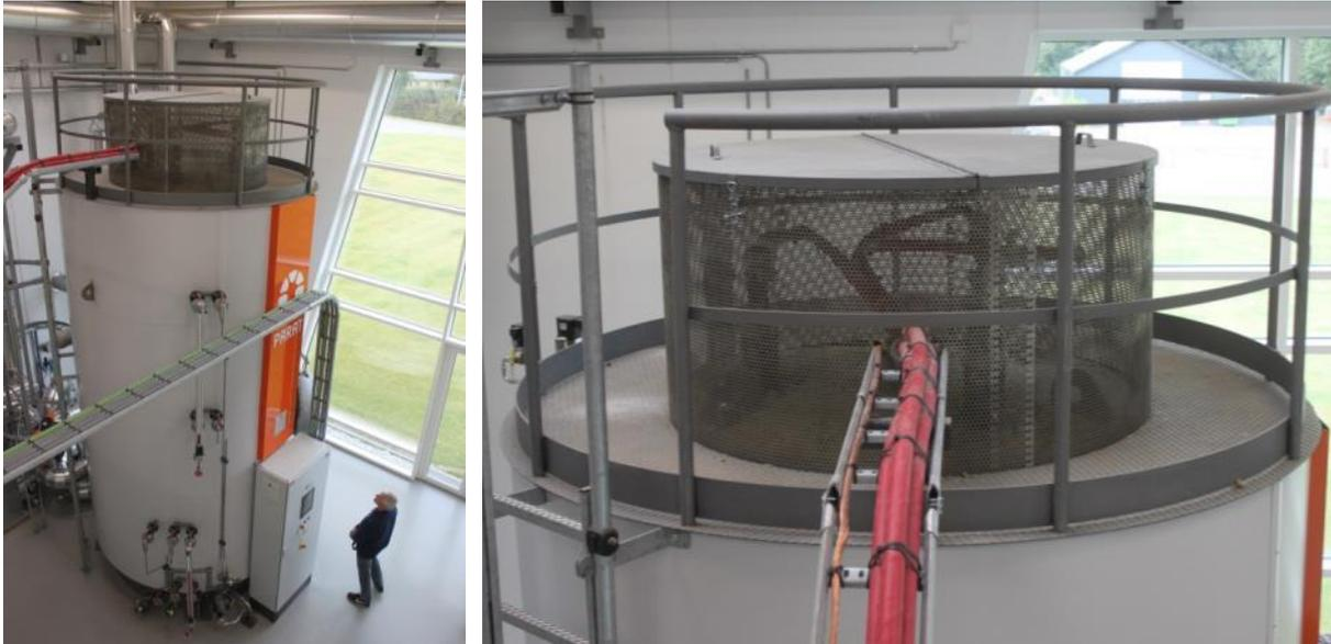
Abbildung 33: 10 MW Elektrokessel mit 14,4 m<sup>3</sup> Speichervolumen des solaren Wärmenetzes in Gram, Dänemark (Quelle: Rutz D.)
