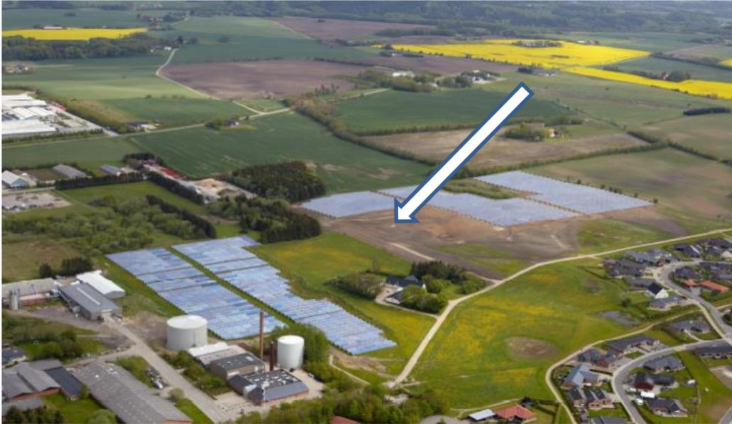
Abbildung 46: Erdsondenwärmespeicher einer Solarthermie-Fernwärmanlage in Brædstrup, Dänemark (Quelle: PlanEnergi)
