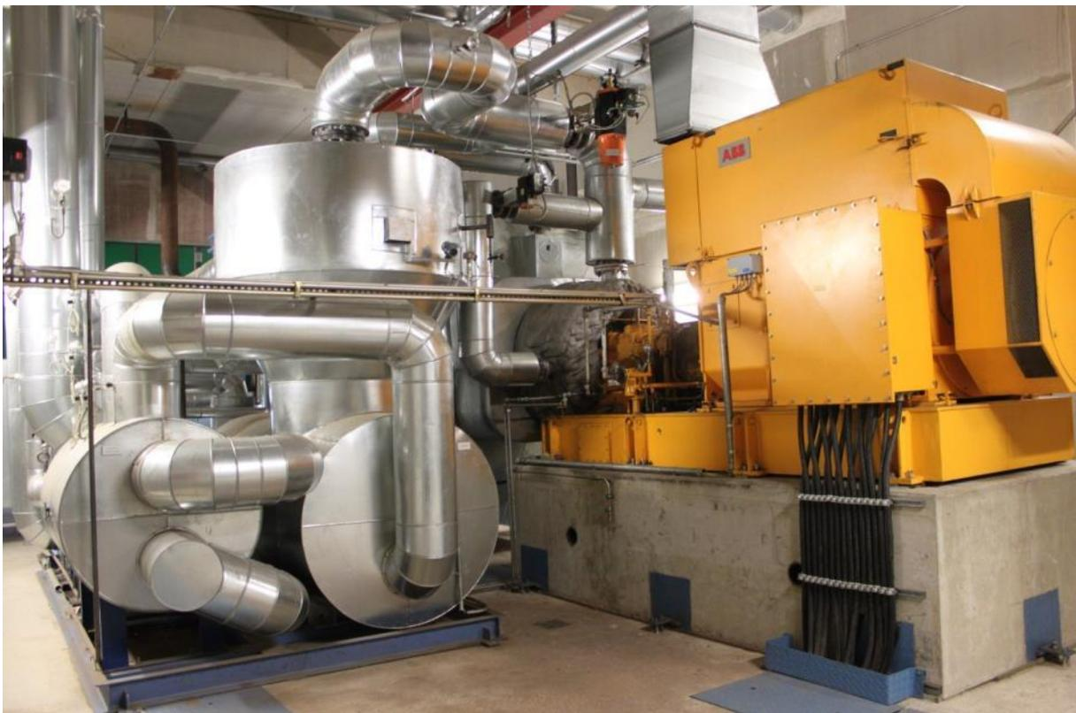
**Abbildung 20:** ORC Anlage (1.520 kW<sub>el</sub>) der Grünfuttertrocknungsgenossenschaft Kirchdorf a.H. eG in Deutschland (Quelle: Rutz D.)
