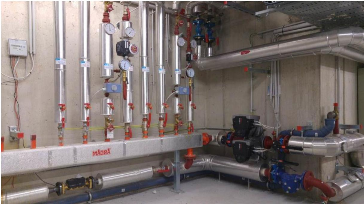
Abbildung 58: Wärmeverteilung eines Gewerbegebäudes mit Fernwärmeversorgung (Quelle: Güssing Energy Technologies)
