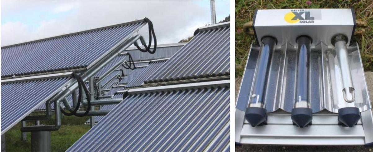
**Abbildung 7:** Vakuurröhrenkollektoren der Freiflächenanlage (links) des solaren Nahwärmenetzes in Büsingen, Deutschland, und Beispielsexemplar dieser Kollektoren (rechts) mit dem U-förmigen Wärmeträgerrohr in der rechten Röhre sowie der Compound Parabolic Concentrator (CPC ) Technologie (Quelle: Rutz D.)
