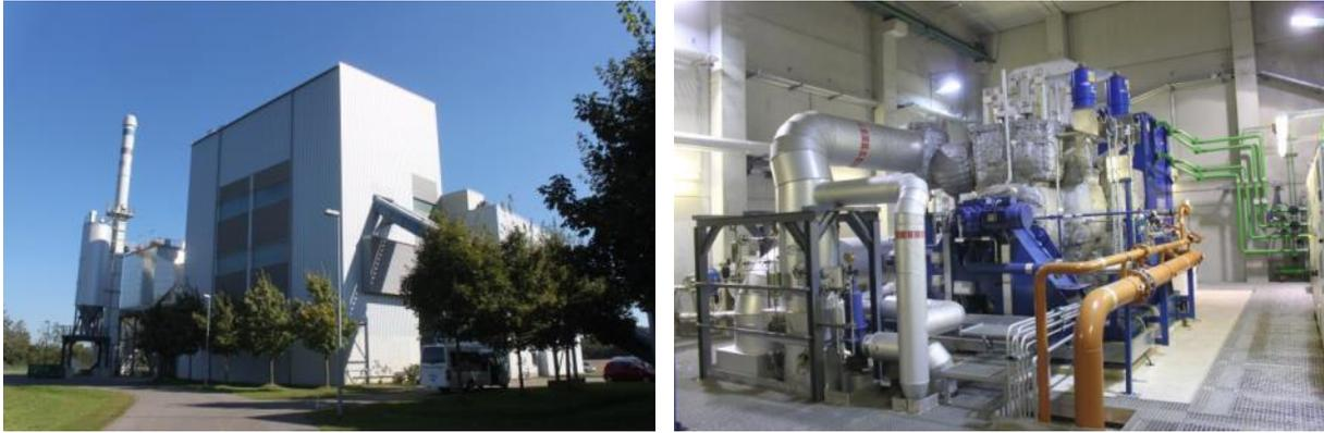
**Abbildung 19:** Holzhackschnittelbetriebene KWK-Anlage und dessen Dampfturbine der Stadtwerke Augsburg Energie GmbH in Deutschland (Leistung: 80.000 t/a Hackschnittel; 7,8 MW<sub>el</sub>; 15 MW<sub>th</sub>) (Quelle: Rutz D.)
