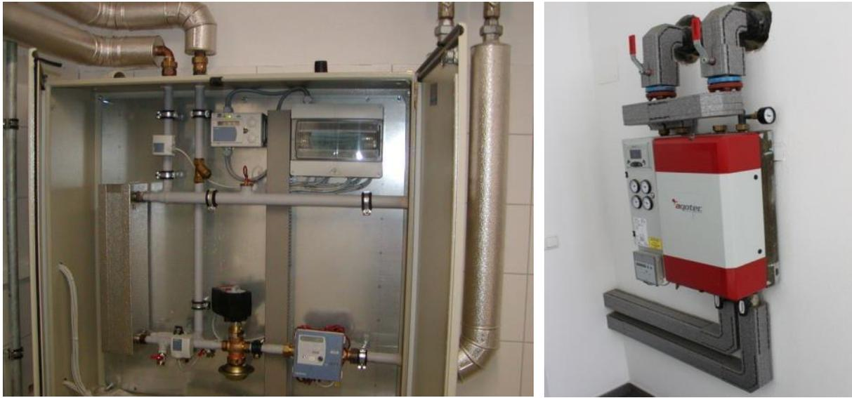
**Abbildung 55: Wärmeübergabestation mit Wärmetauscher, Regler, Ventilen und Wärmemengenzähler (links) (Quelle: Güssing Energy Technologies) und Wärmeübergabestation (mit Wärmetauscher) eines Abnehmers in Achtental, Deutschland (Quelle: Rutz)**
