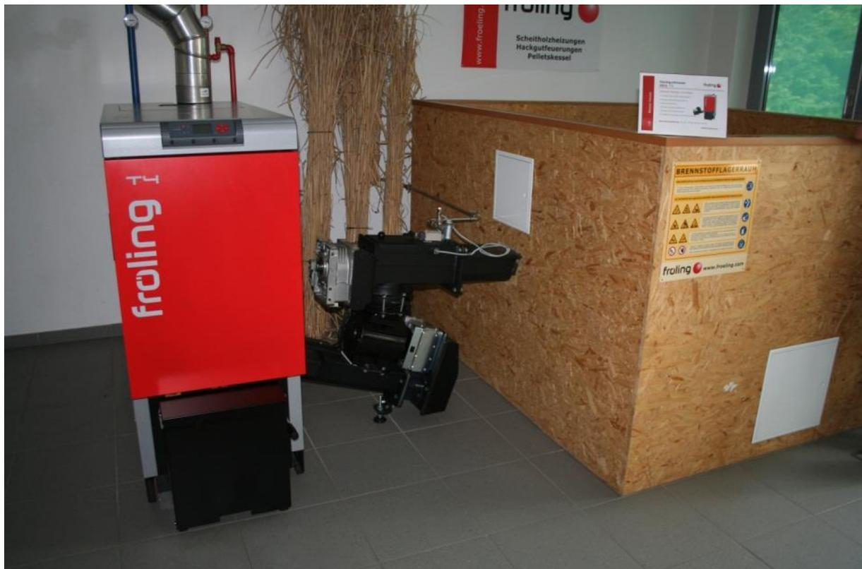
Abbildung 15: Kleines Hackschnitzelheizsystem (24-50 kW Heizkapazität) von der Firma Fröling mit dem Boiler (links), der Zuführeinrichtung (Mitte) und dem Hackschnitzelbunker (rechts) (Quelle: Rutz D.)
