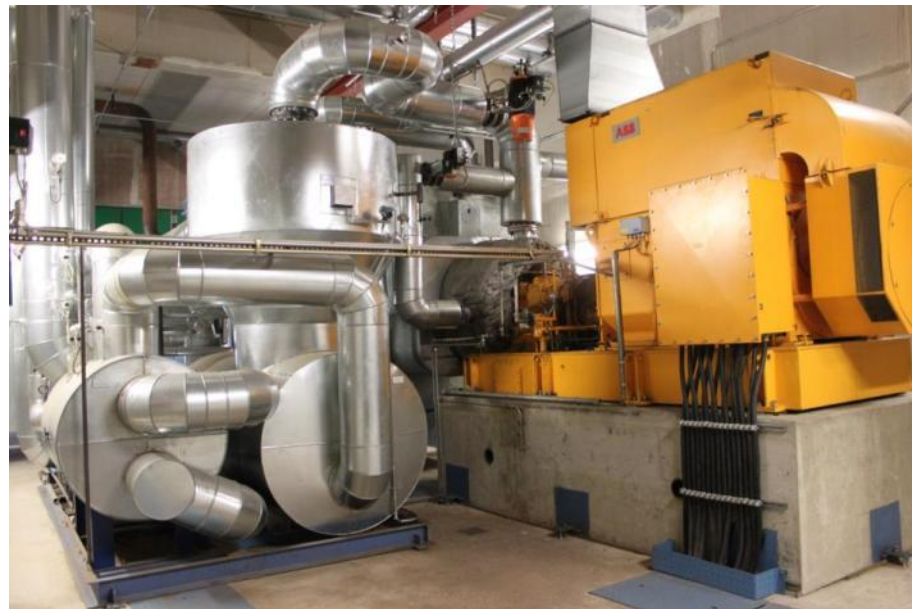
ORC систем (1,520 kW el ) во Grünfuttertrocknungsgenossenschaft Kirchdorf Германија, (Извор: Rutz D.)
