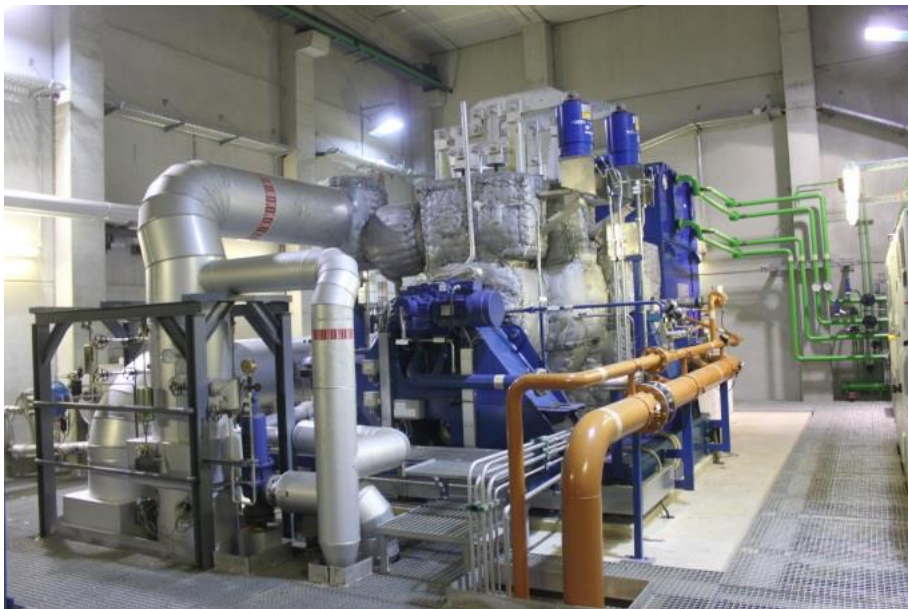
CHP на дрвен чипс и неговата парта турбина во Аугзбург (капацитет: 80000 t дрвен чипс/год, 7,8 MW el , 17 MW th ) (Извор: Rutz D.)
