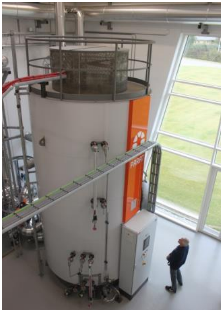
Električni bojler snage 10 MW te kapaciteta 14.4 m 3 u CTS-u u Gramu, Danska (Izvor: Rutz D.)
