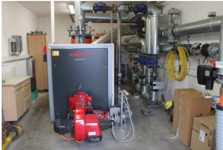
Vršni kotao na lož ulje u bioplinskom postrojenju u Njemačkoj (Izvor: Rutz D.)
