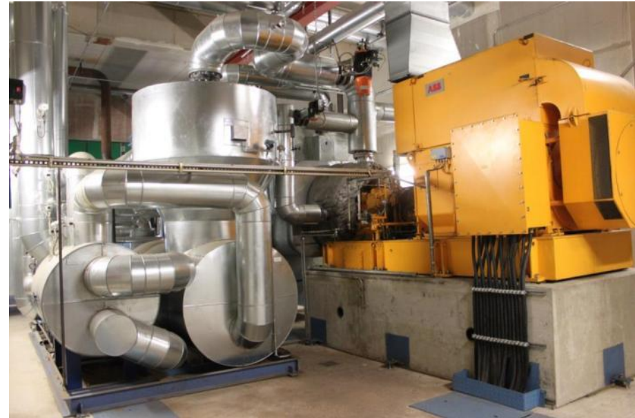
ORC sustav (1,520 kW el ) u mjestu Grünfütterrocknungs-genossenschaft Kirchdorf u Njemačkoj (Izvor: Rutz D.)
