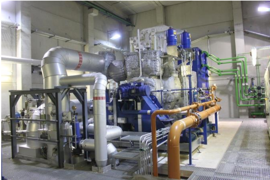
Kogeneracijsko postrojenje na drvenu sječku te njegova parna turbina u Augsburgu (kapacitet: 80,000 t/god drvene sječke; 7.8 MW el ; 15 MW th ) (Izvor: Rutz D.)
